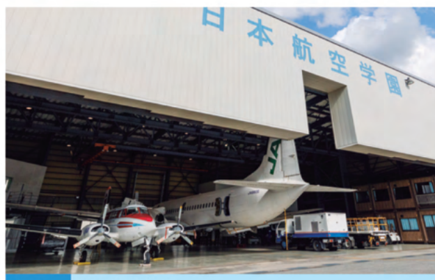
V 大型機格納庫
