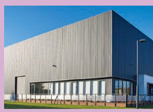
実習棟キャビントレーニングセンター
